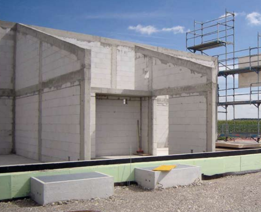
◀ Kindergarten in Parsdorf: Das Innere besteht vor allem aus Kalksandstein und Stahlbeton, ...
