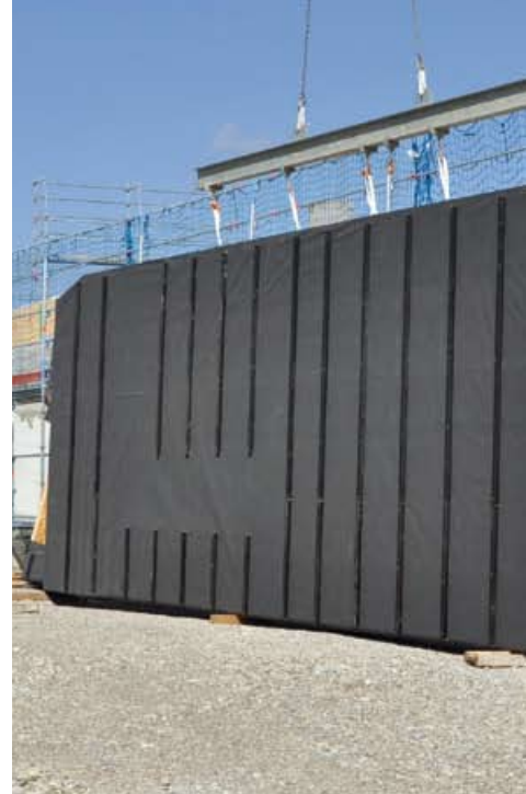
▶ ... die Außenhülle aus großen vorgefertigten Holzrahmenbauelementen
